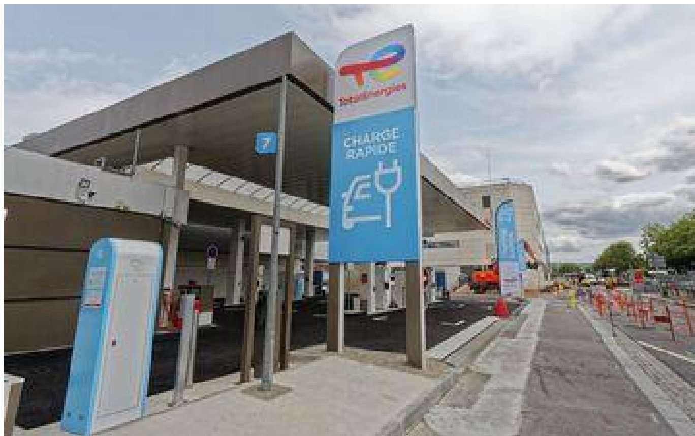
À Rouen, Total Énergies ouvre sa 3e station-service 100 % électrique de France
